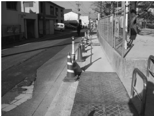
写真0 歩道の設置工事
